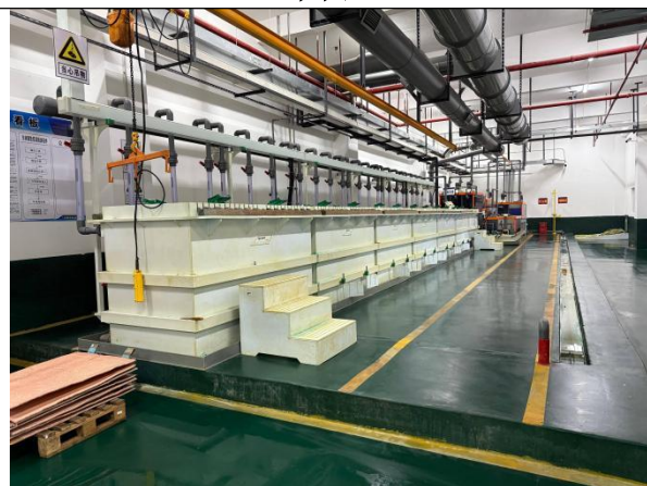
车间地面防渗
